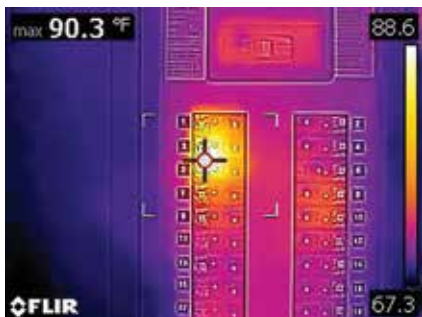
方框区域中的热点表明电气保险丝正处于工作状态
