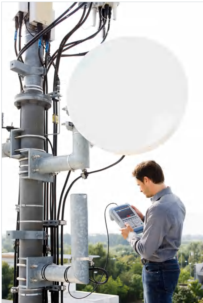
在安装和维护发射站时使用 R&S®FSH
