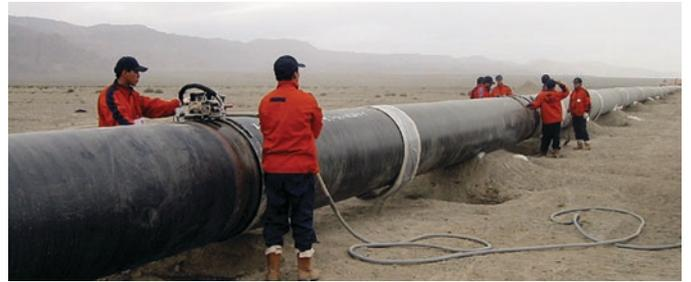
PipeWIZARD系统已经检测了超过一百万条焊缝。
