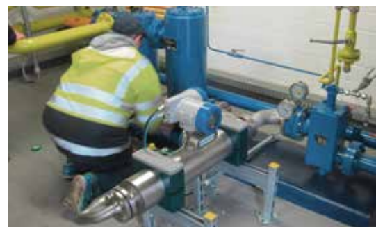
基于 MID MI-005 贸易交接指令的液化气体的装车系统
